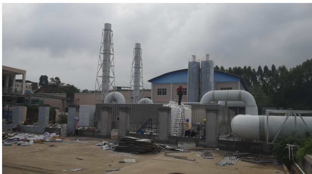
图 3.6 生物除臭设施及排气筒
