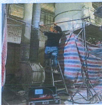
废气排放口 DA001
