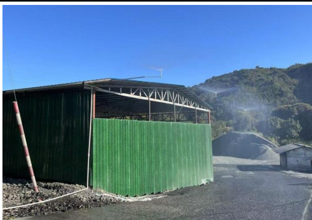
铁矿砂堆场围挡+水喷淋
