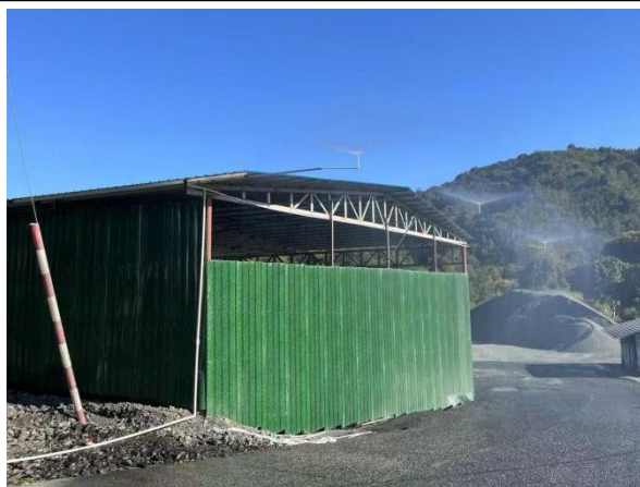
铁矿砂堆场围挡+水喷淋
