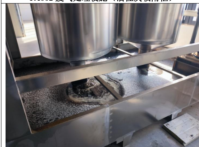
TA002 废气处理设施（气旋混动喷淋塔循环水池）
